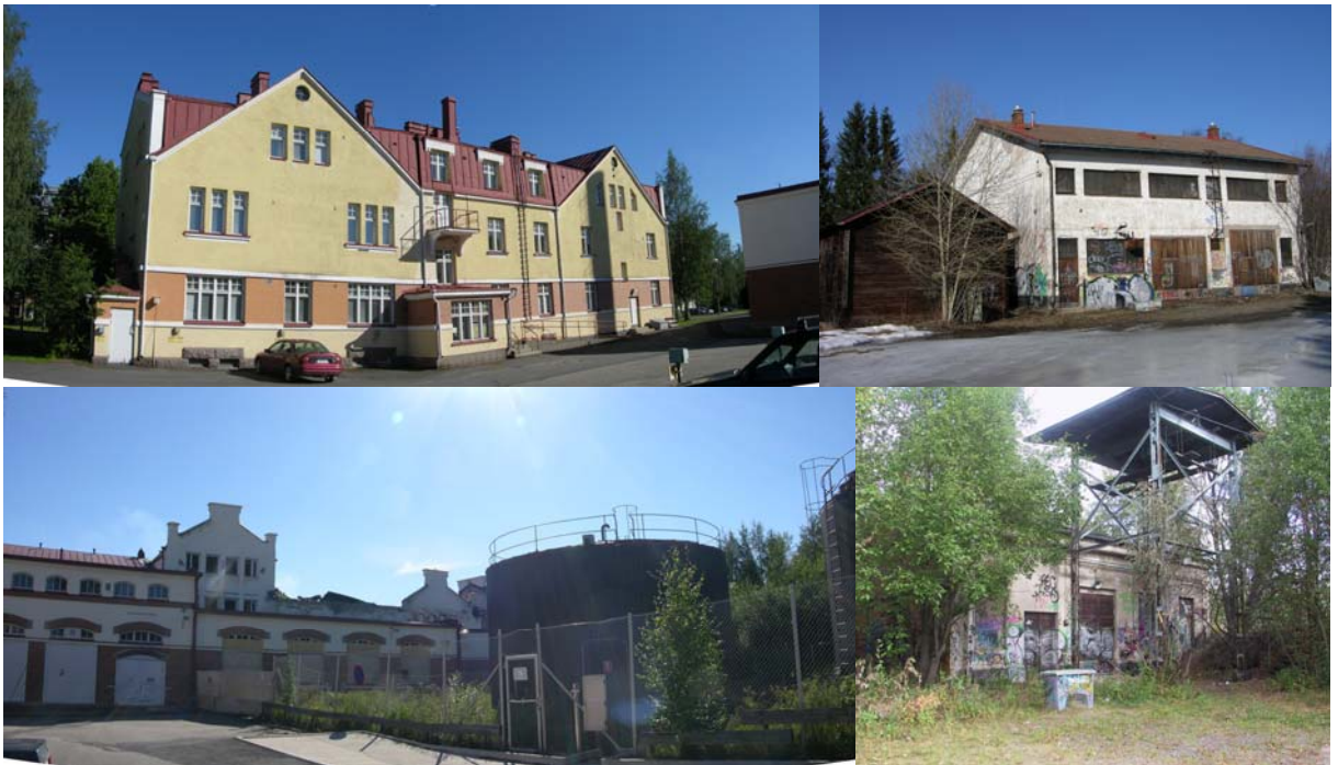
Kuvat 12-15. Vasemmalla entinen konttorirakennus sekä entinen voima-asema ja lämpökeskuksen öljysäiliöt, oikealla Sahasaaren talli- ja korjaamorakennukset sekä pajarakennus.
